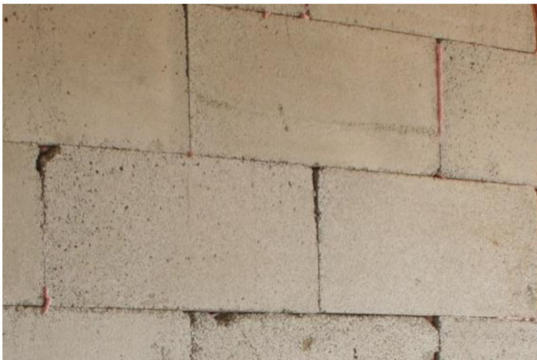
الشكل (1و) وحدة بناء مصنوعة من خرسانة خفيفة الوزن وتم استخدام عديد الستايرين (polystyrene) في صنعها
